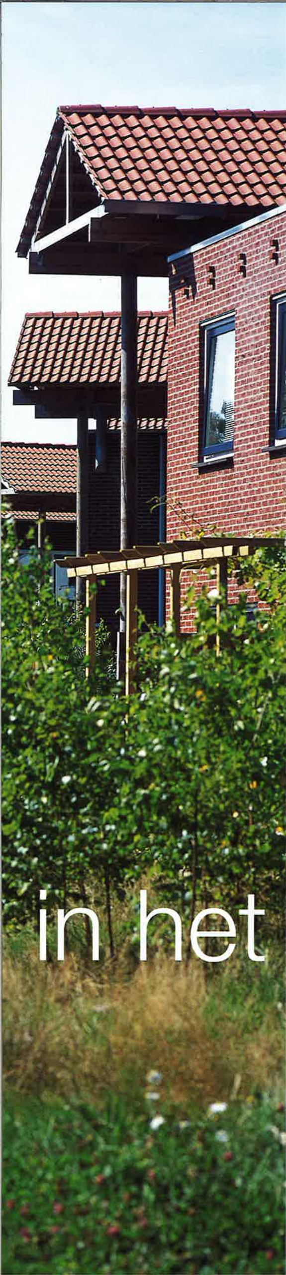
'Berkenbos' woningen in Zuidlaren (Faro Architecten)
