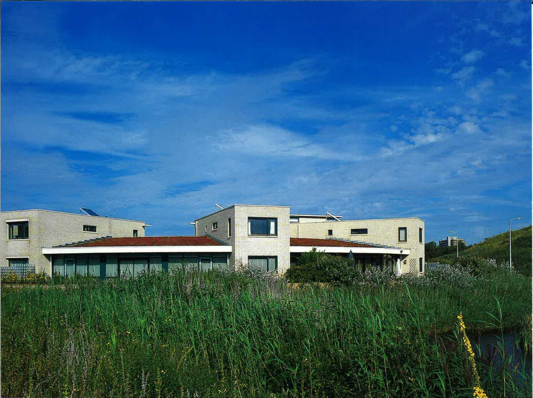
'Duinwoningen' in Kijkduin, Den Haag (van Tilburg en partners)
