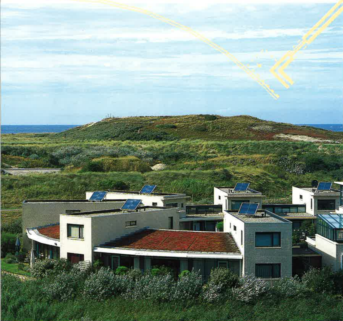
'Duinwoningen' in Kijkduin, Den Haag (van Tilburg en partners)
